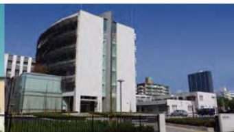
平成29年 現在の工業技術センター
