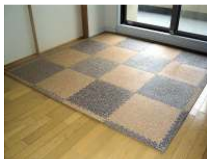
図 3 繊維コルク複合体の床材への施工
