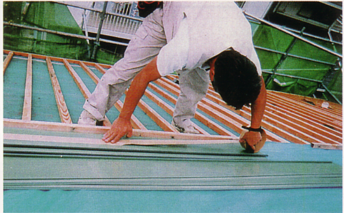
制振テープを用いた金属屋根の施工
