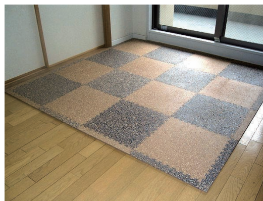
床材への施工風景
