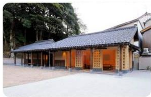
黒いぶし瓦施工例:城崎駅前通り公園休憩所
