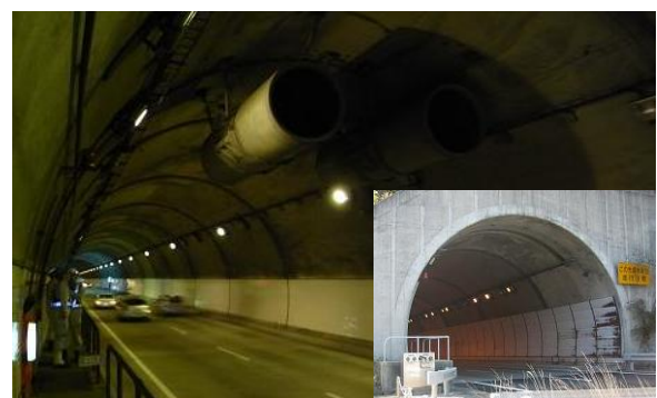
実験を行ったトンネル
