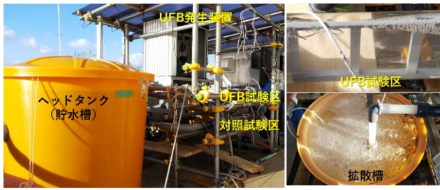
図2 海水実証試験用設備の設置状況
