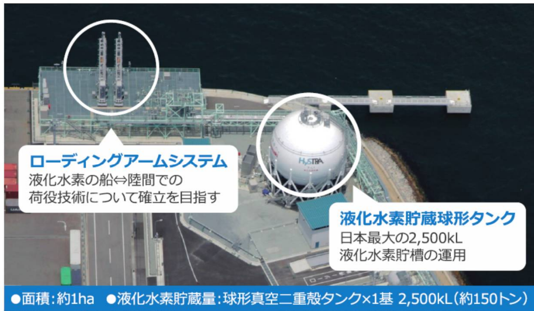
液化水素荷役基地（神戸空港島）
