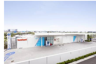
イワタニ水素ステーション羽田空港
